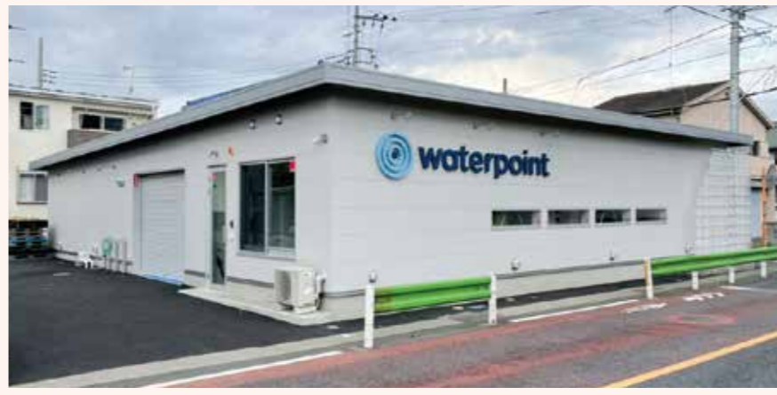
2022年、東京都八王子市に建設した防災型宅配水工場
